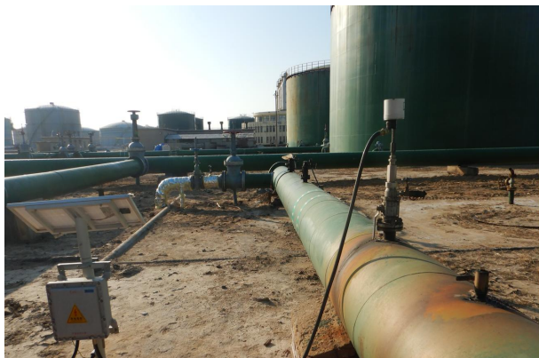
图 3. CST1810 电化学腐蚀监测仪安装现场和 CP-81 线性极化探头
